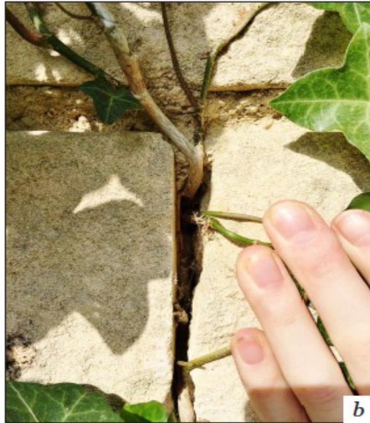
a. agrandissement d'un joint par effet vérin. b. accumulation de tiges dans un joint
